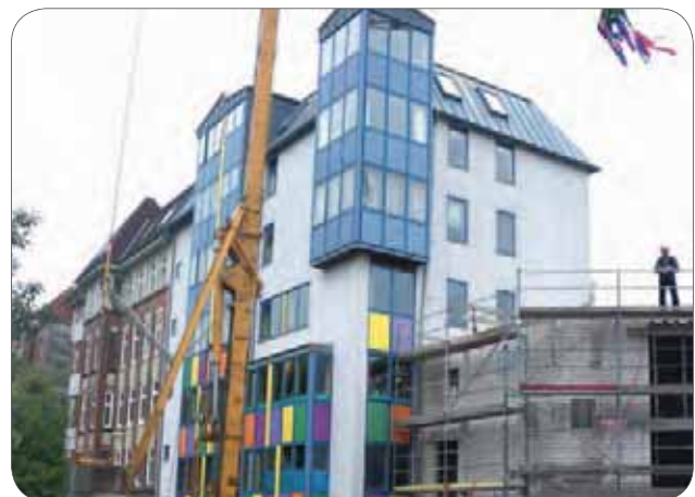
Richtfest: DRK-Kita Stadtfeldkamp baute an
